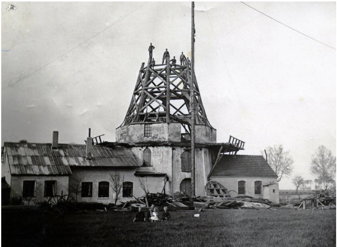
Bild 2: Um 1930 - die Oyter Mühle wird zurückgebaut.
